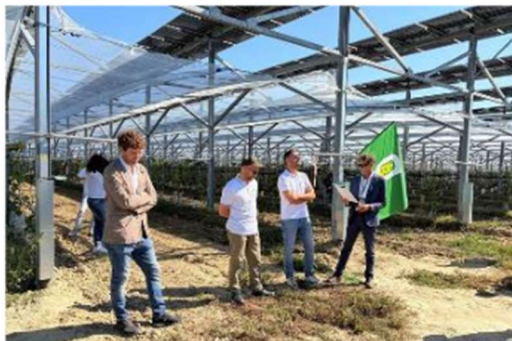
L'impianto agrivoltaico installato dall'azienda agricola CaNova di Faenza
