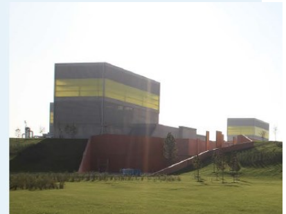
Sopra, L'Eni Green Data Center. Nel box a lato, Sergio Zazzera. In alto, Alessandra Ferrari
