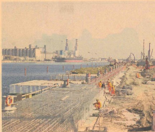
Scalo marittimo. Lavori in corso nell'area del porto di Ravenna
