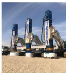
Un cantiere del Gruppo Trevi
