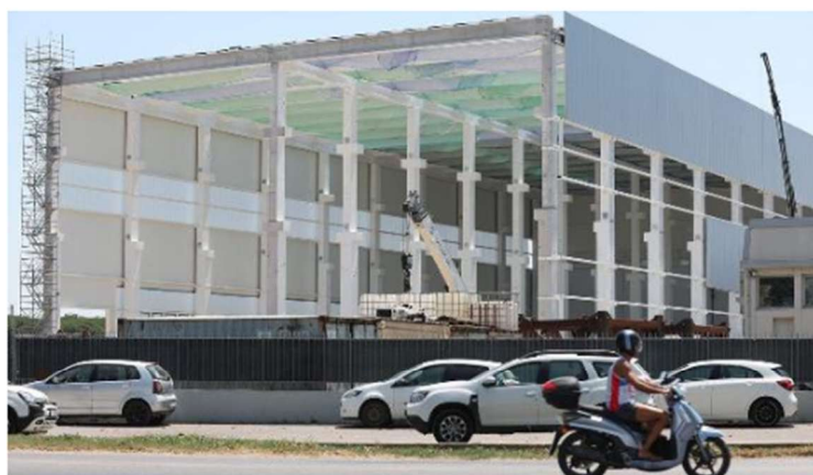
Il capannone in costruzione in via Trieste. A destra Renzo Righini, amministratore delegato dell'azienda
