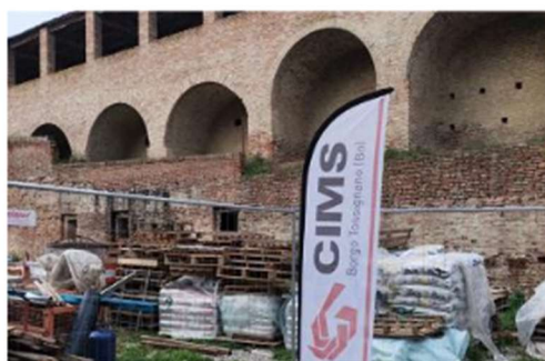
Un cantiere della Cims, colosso cooperativo in difficoltà economica
